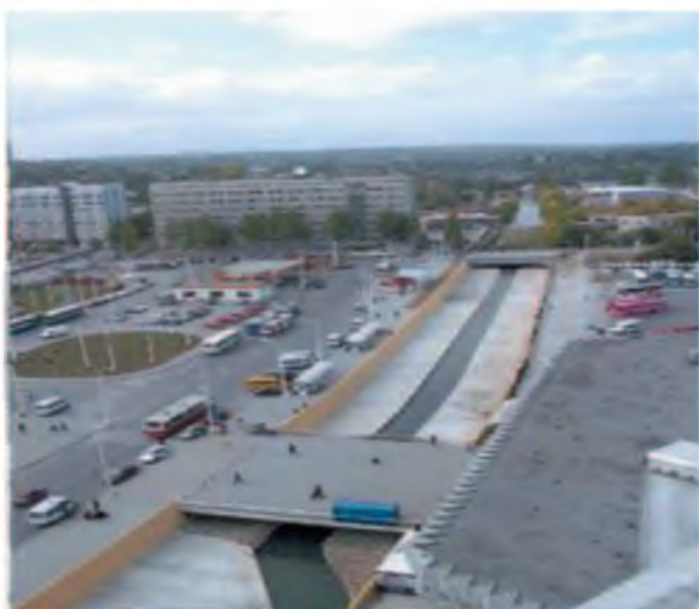
Фото 8. Расчищенный и благоустроенный участок реки Темерник в районе Главного железнодорожного вокзала
