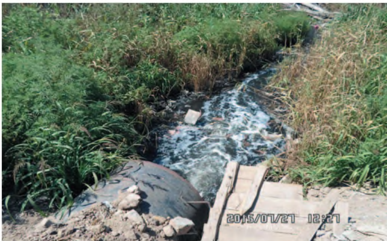
Фото 6. Организация автомобильного переезда в районе притока Малая Камышеваха
